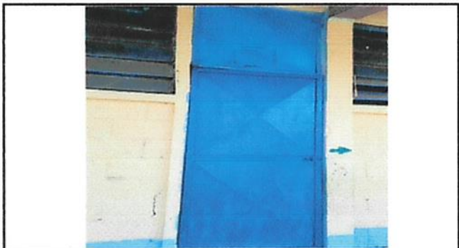
MANTENIMIENTO DE PUERTAS
