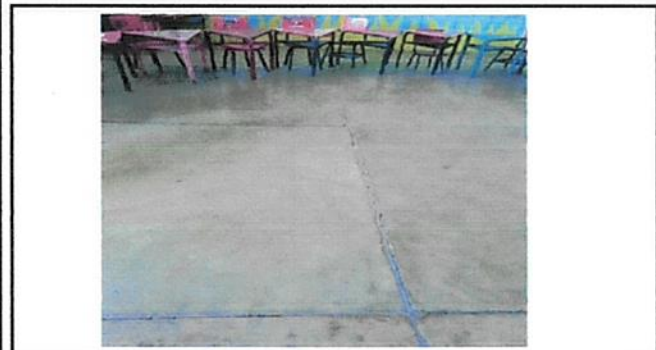
SUSTITUCION DE PISO DE GRANITO
