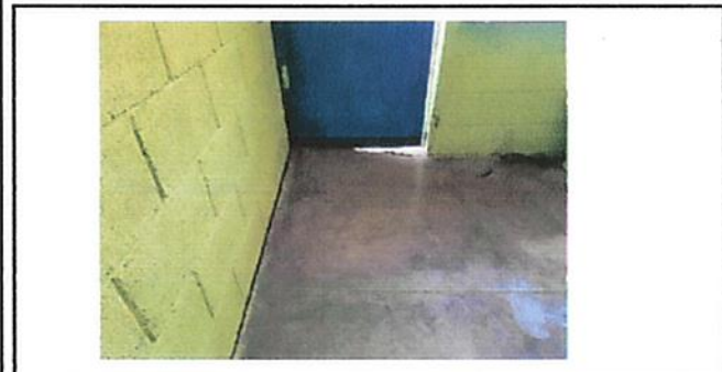
SUSTITUCION DE PISO DE GRANITO
