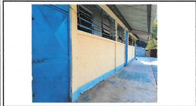
REPARACION DE PARED
